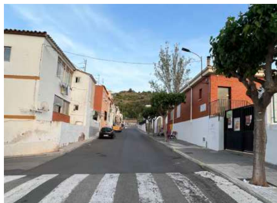
Fotografía de estado actual de la calle C
