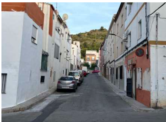
Fotografía de estado actual de la calle B
